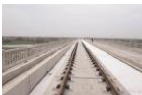
Рисунок 1. Строительная площадка по прокладке безбалластного пути для высокоскоростной железной дороги.
