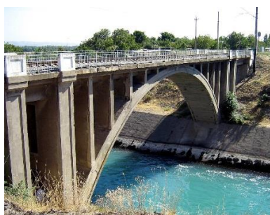
Рис. 3. Арочный мост через водосброс на канале Бозсу
