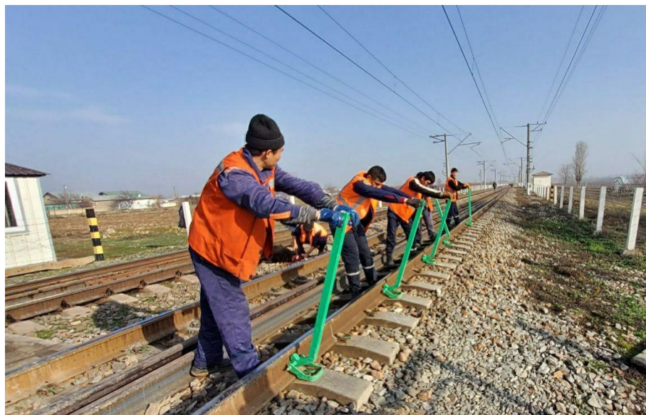
1-rasm. Blok-uchastka uzunligidagi rels pletlerini yotqizish va optimal temperaturada maxkamlash jarayoni [8]
