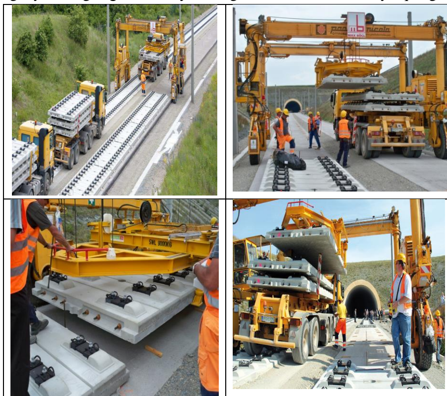
4- rasm. Bogl tipidagi ballastsiz konstruksiya
