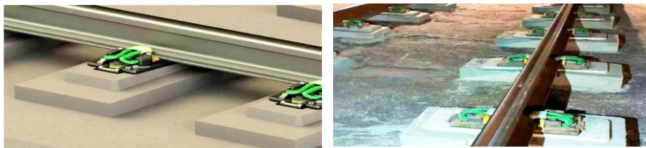
8-rasm. Bozberg/STEDEF tipidagi ballastsiz konstruksiya.
