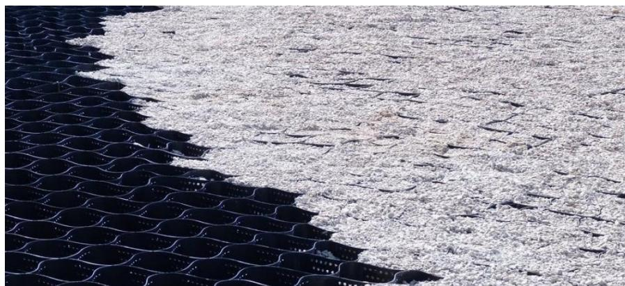
Рисунок 2. Георешетки используются для армирования насыпи и увеличения несущей способности грунта.
