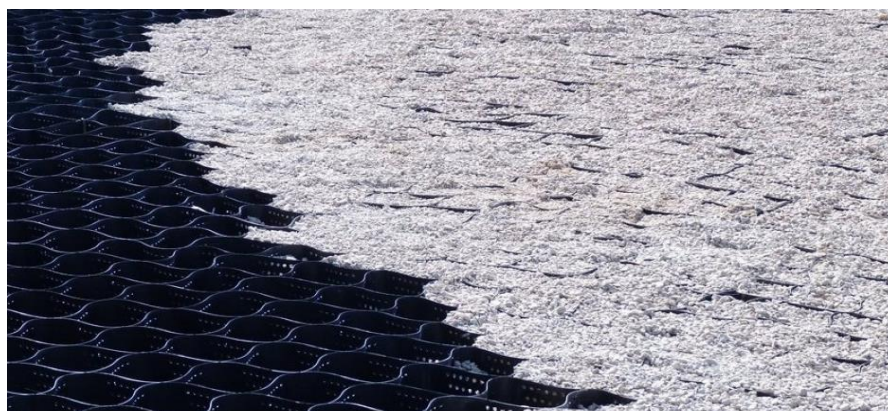
Рисунок 2. Георешетки используются для армирования насыпи и увеличения несущей способности грунта.
