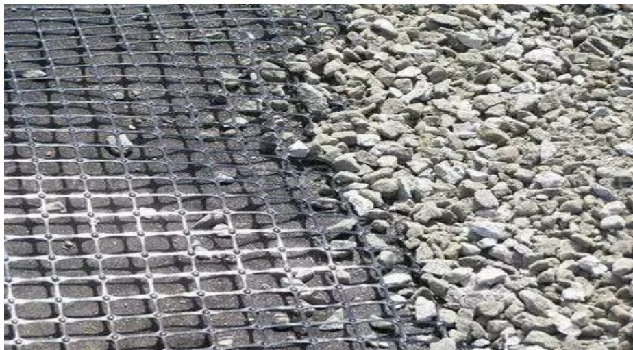
Рисунок 4. Геосетки используются для улучшения распределения нагрузок.
