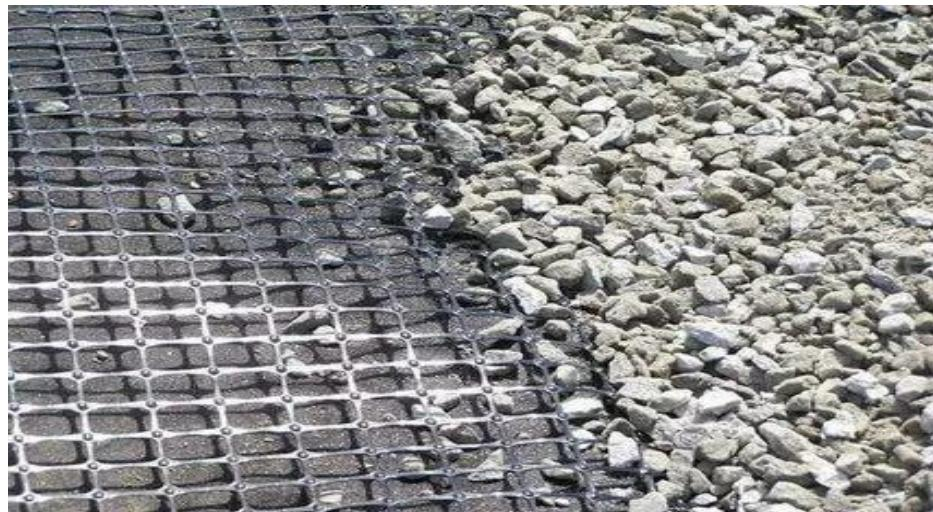
Рисунок 4. Геосетки используются для улучшения распределения нагрузок.
