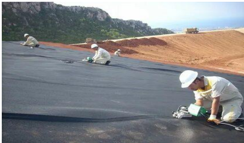
Рисунок 3. Геомембраны используются для предотвращения проникновения воды в насыпь.
