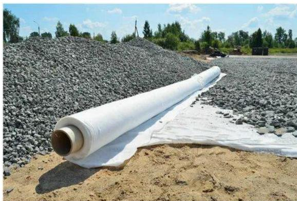
Рисунок 1. Укладка геотекстиль на ЗП.
