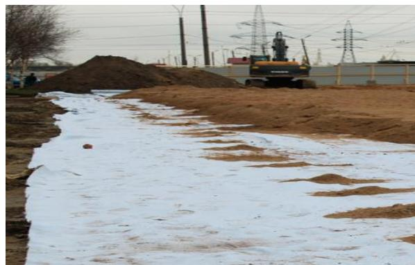
2. Геосетки (Geonets) - полимерные сетчатые структуры с ромбовидной формой ячеек, сформированные двумя наложенными друг на друга пересекающимися нитями, которые образуют комплекты сплошных глубоких каналов, обеспечивающих высокую способность к просачиванию жидкости;
