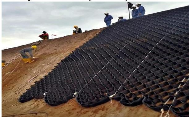
4. Геоячейки (Geowebs, Geocells), или объемные георешетки - представляют собой конструкции из синтетических лент, скреплённых между собой посредством сварных швов таким образом, что при растяжении в поперечном направлении они образуют сотовидную конструкцию;
