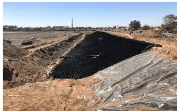
Узбекистан, обладая значительной протяженностью железных дорог и разнообразными климатическими условиями, активно внедряет современные технологии для усиления железнодорожного полотна. Использование геотекстиля и геосеток в Узбекистане значительно увеличило срок службы железнодорожных путей. В ряде проектов внедрение этих материалов позволило сократить расходы на ремонт и увеличить интервал между капитальными ремонтами.
