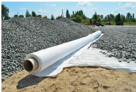
Рисунок 1. Укладка геотекстиль на ЗП.
