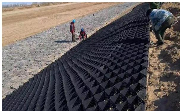
5. Геомембранные абсолютно непроницаемые материалы, выпускаемые в виде пластин, рулона и используемые в геотехническом, гидротехническом и транспортном инженерном строительстве. Синтетические геомембранные - геомембранные, изготовленные в основном из синтетических структур, таких как полиэтилен, полипропилен и др. Битумные геомембранные – геомембранны.
