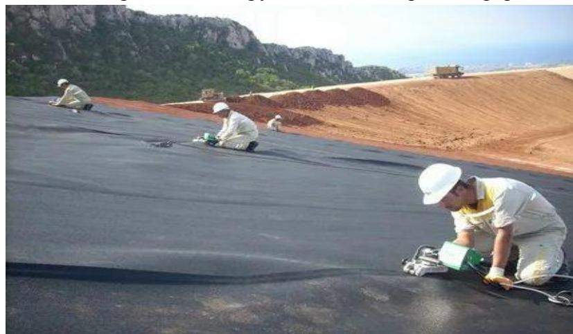
Рисунок 3. Геомембранны используются для предотвращения проникновения воды в насыпь.
