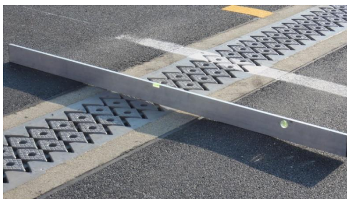
Рис. 2. Устройство переходных зон из полимербетона
