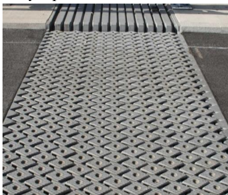
Рис. 3. Деформационный шов типа GO с ромбическими элементами
