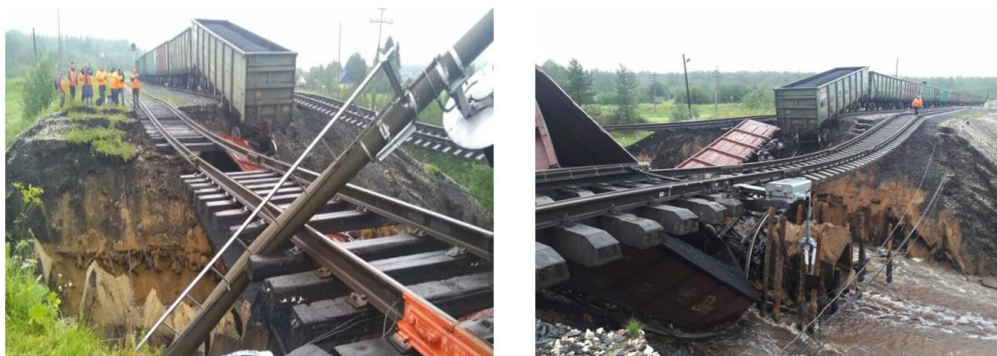
5-расм. Темир йўл тармоғида сув ўтказувчи қувурнинг носоз ҳолатга келиши
