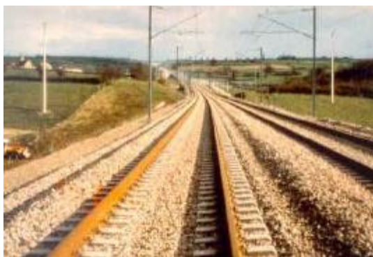
Рисунок 1. Железнодорожная колея с двумя блочными шпалами
