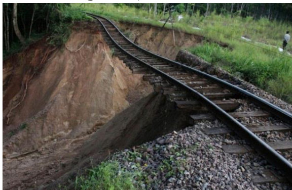
Расм 3. Темир йўл кўтармасидаги грунтларнинг деформацияланиши.
